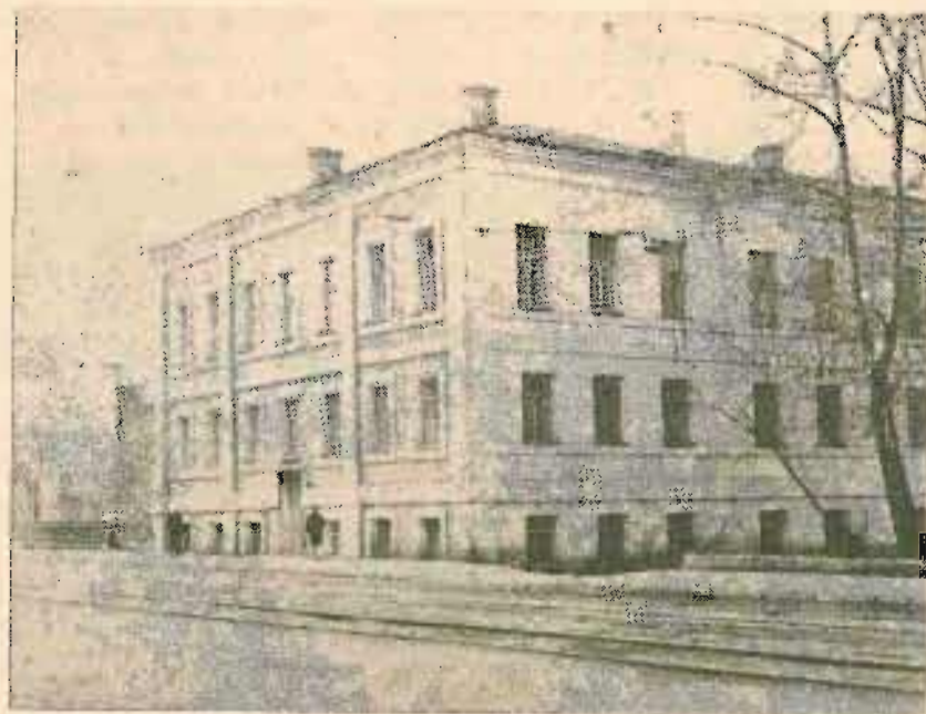
Дом Крюгера на ул. Магистратной, д. 6 (ул. Р. Люксембург, д. 6) (из архива ТМУ)
